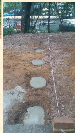
25 個石屎基座完成，方便下周後可以進行安裝工程。
